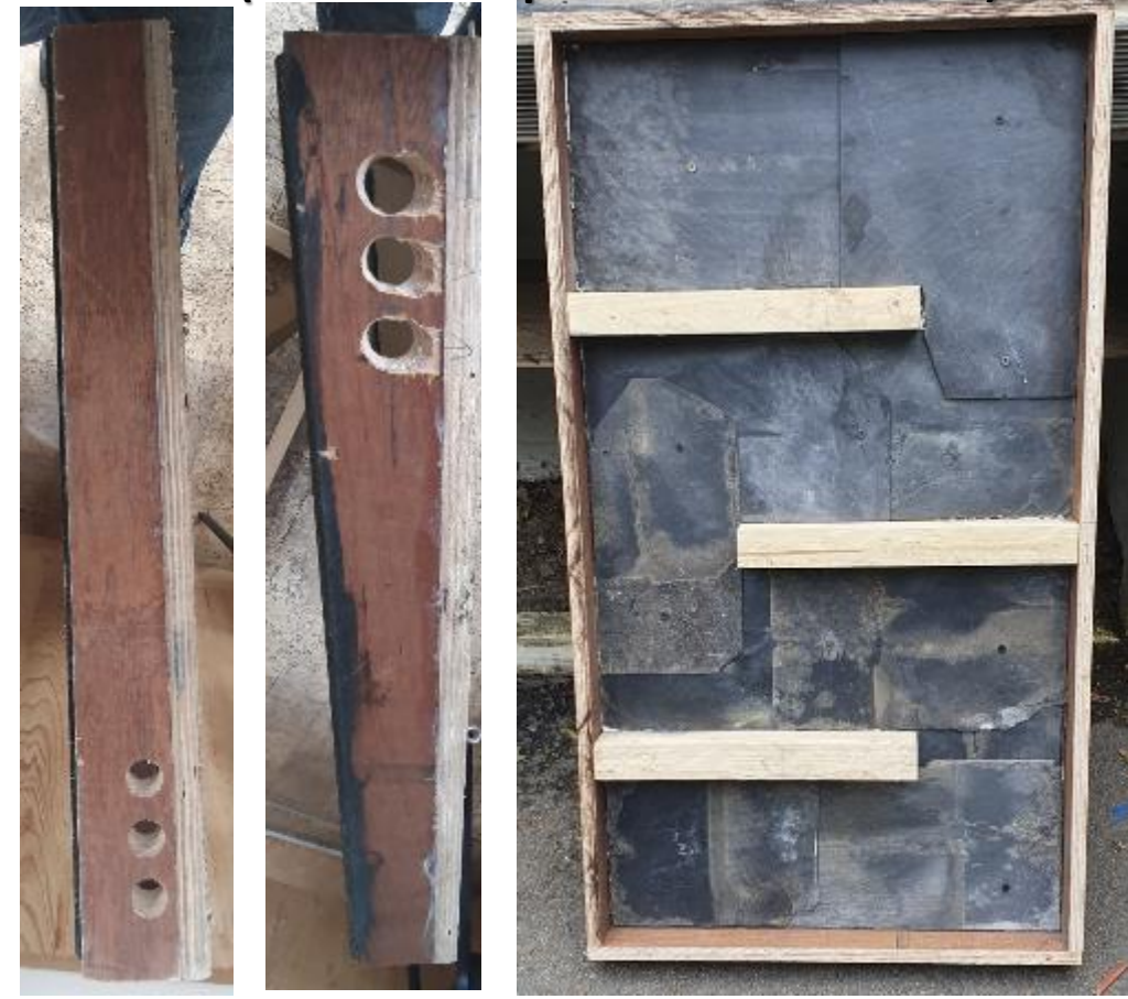
Trous du bas (entrée d'air extérieur)
